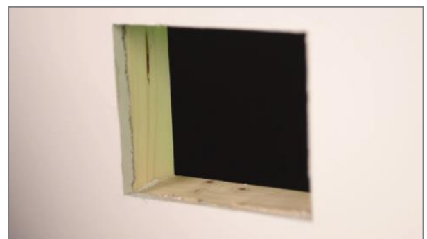
enkele gipsplaat wand met houten frame
